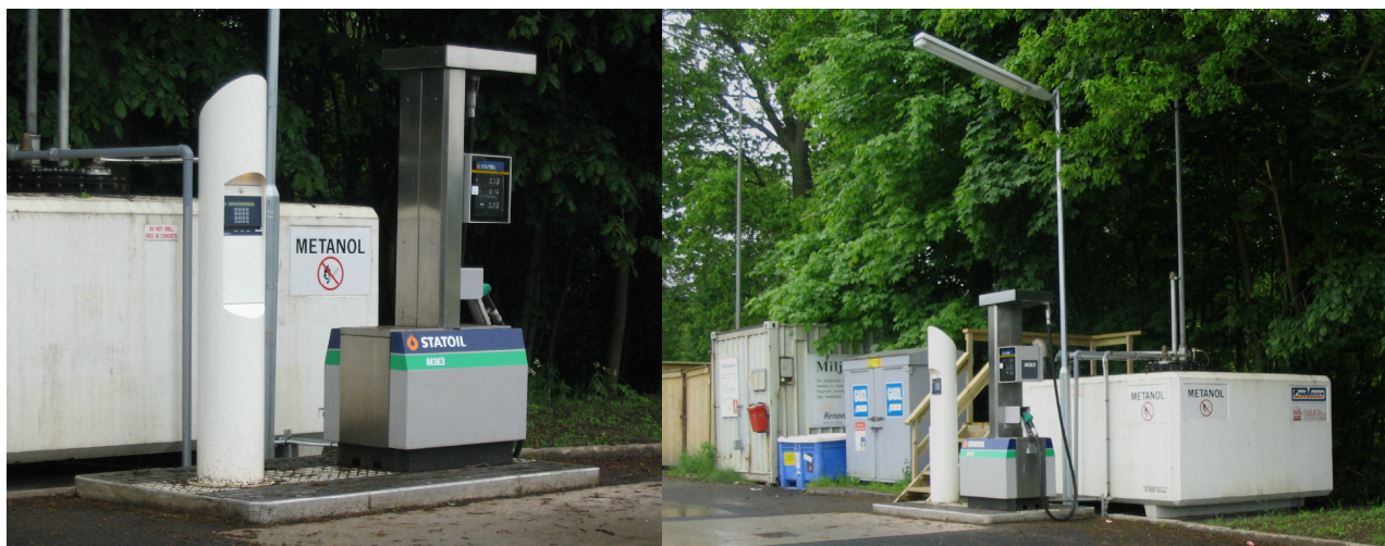
Figur 6. Cistern och pump för flottförsök med M3E3-bensin
